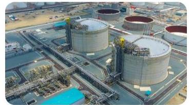
말레이시아 최초의 육상 LNG Terminal 말레이시아 RGT-2 인수기지
